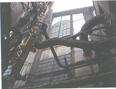
Resim 51. Silahtarağa Elektrik Fabrikası.
