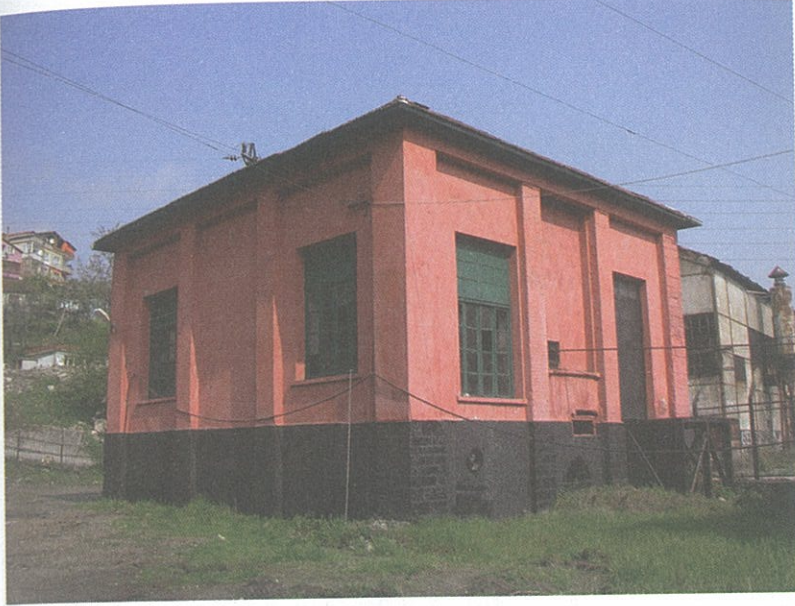
Resim 05. Kozlu İncirharmanı Kuyu Binası.
