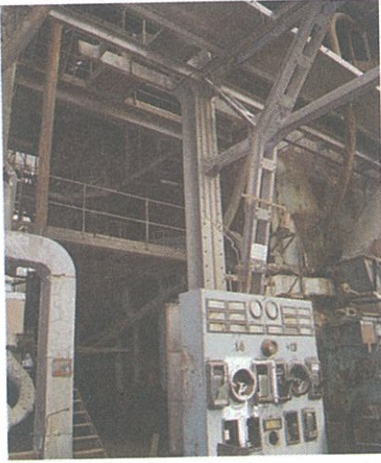
Resim 50. Silahtarağa Elektrik Fabrikası.
