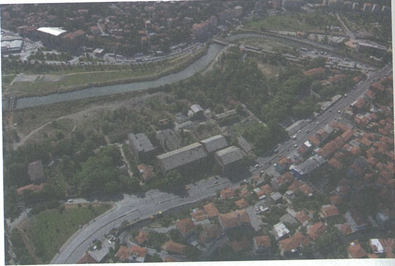
Resim 49. Silahtarağa Elektrik Fabrikası.
