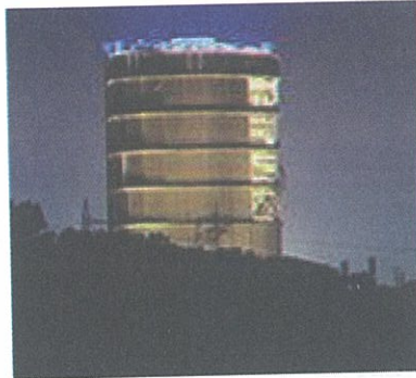
Resim 40b. Gaz deposu.
