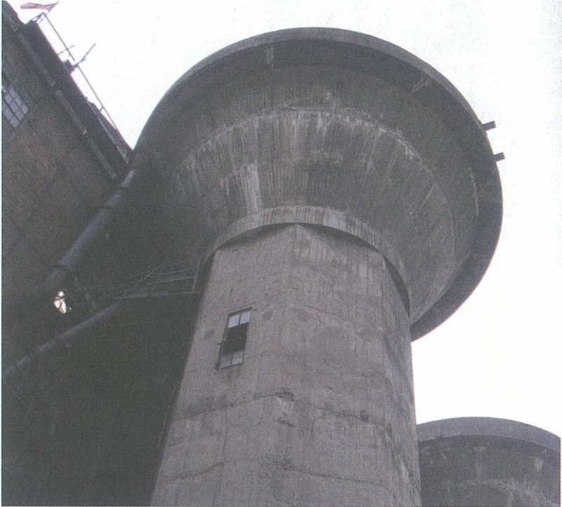
Resim 16. Çatalağzı Lavuarı, kuleler.
