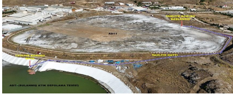
Şekil 5: ADT-1 Alanından ADT-2(Sulu Atık) Alanı Görünümü ve Tahliye Borusu
