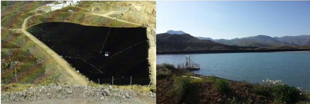
Şekil 4: Kaplama işlemleri tamamlanmış ve aktif şekilde kullanılmış olan ADT
