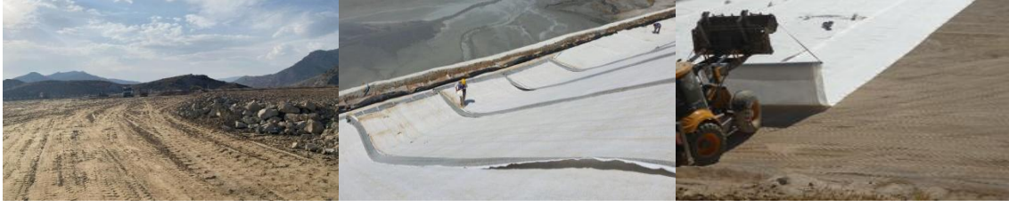
Şekil 7: Tampon tabaka, GCL ve geokompozit drenaj tabakası uygulaması (Kürtünlüoğlu ,2025)
