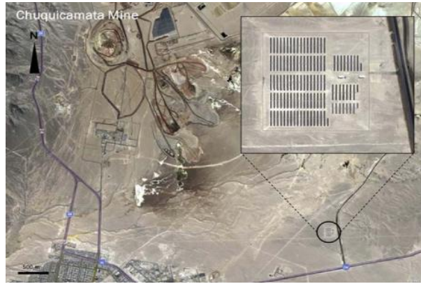
Şekil 1: Şili, Chuquicamata Madeni yakınlarındaki Calama Solar 3 enerji tesisinin havadan görünümü (görüntü kaynağı: Bing Maps, http://www.bing.com/maps ).
