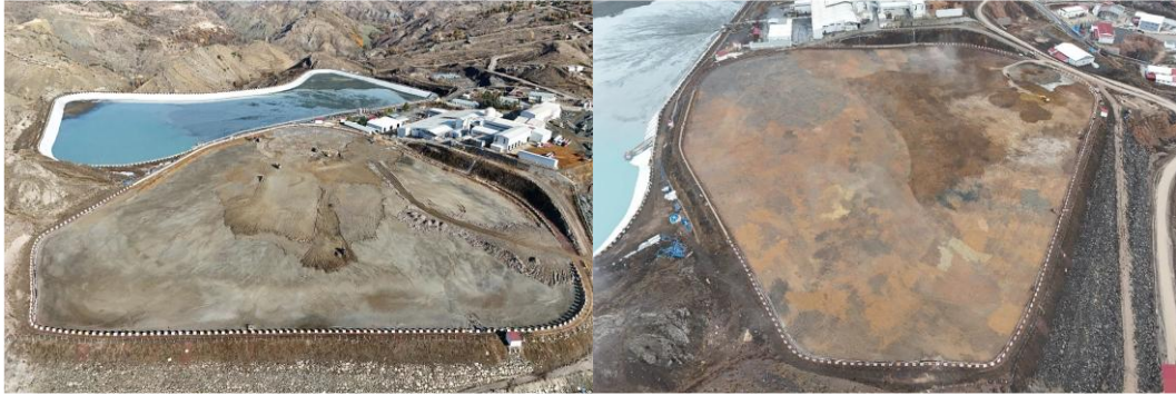
Şekil 6: Rehabilitasyon çalışmaları yapılmaya başlanan ADT-1 alanı kapatma aşamalarına dair fotoğraflar
