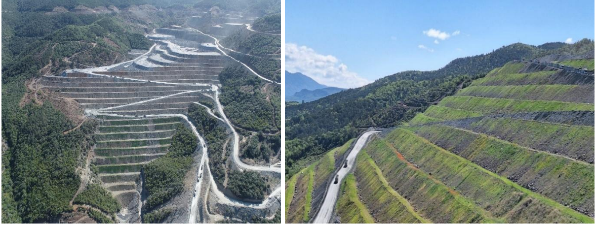
Şekil 5: Eş zamanlı rehabilitasyon çalışması
