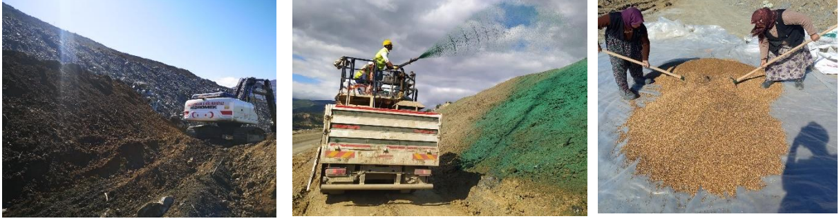
Şekil 1: Bitkisel toprak serimi-Hydromulching-Tohum karma işi
